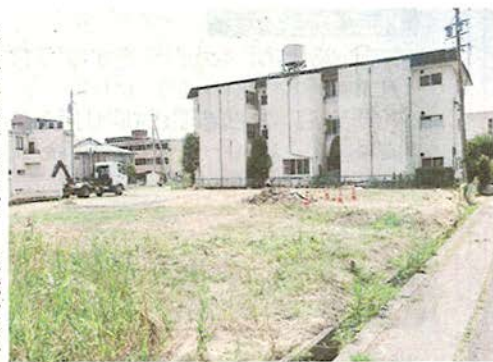
上田市中心部の材木町のアパート建設予定地。奥にある既存のアパートを改修し、別に3棟を新設して中心に中庭を設ける
