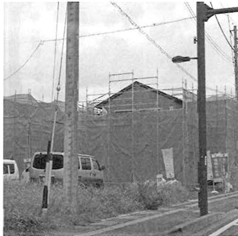
建設ラッシュの新築アパート
